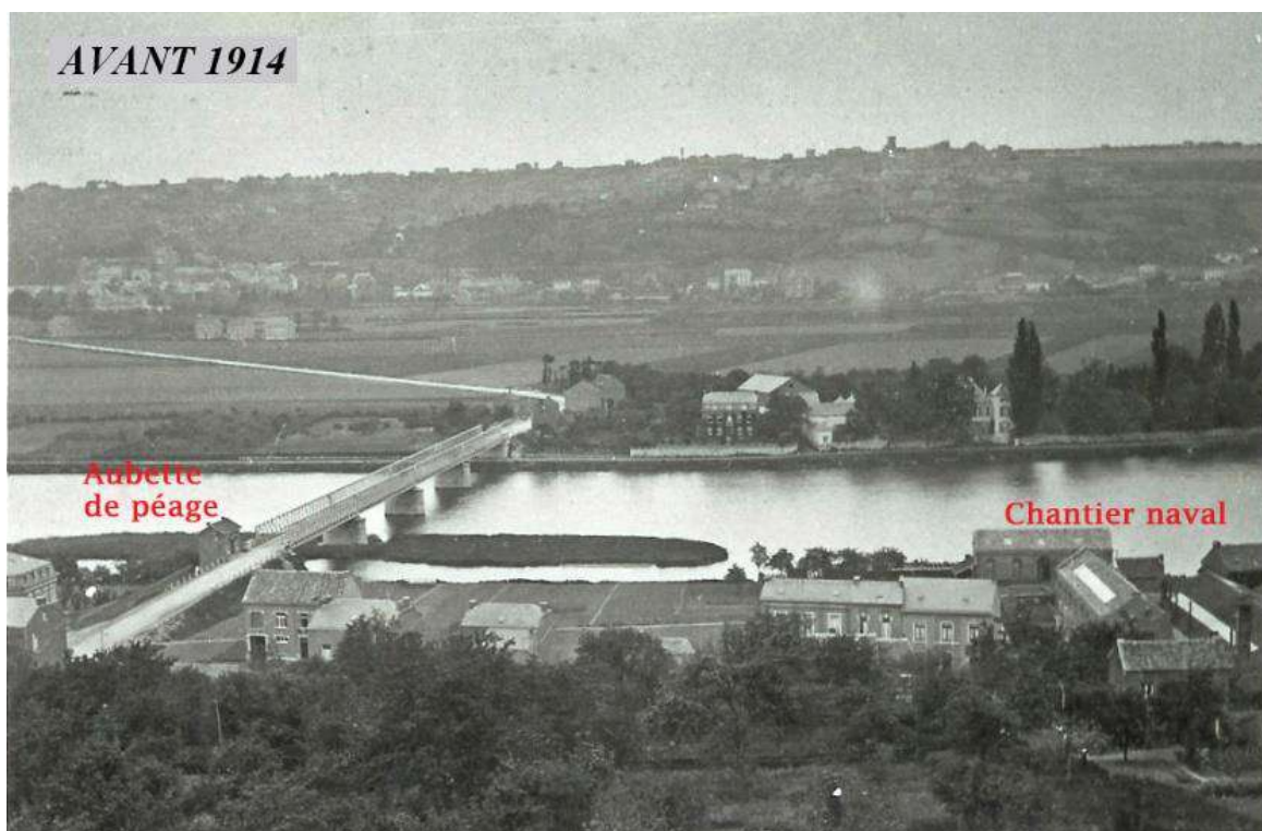
Le pont métallique sur la Meuse construit en 1870 reposait sur une pile établie sur l'île du Centre
