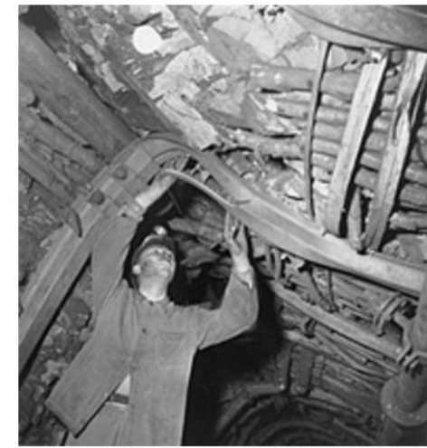
Parfois la déformation est trop importante pour que le cadre puisse rester fonctionnel
