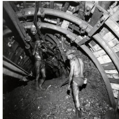
Parfois la déformation est trop importante pour que le cadre puisse rester fonctionnel
