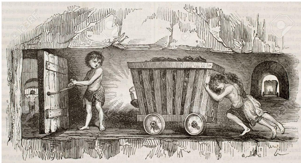
Transport par bac sur plancher ; opérateur de porte de séparation des flux d'air frais et d'air pollué
