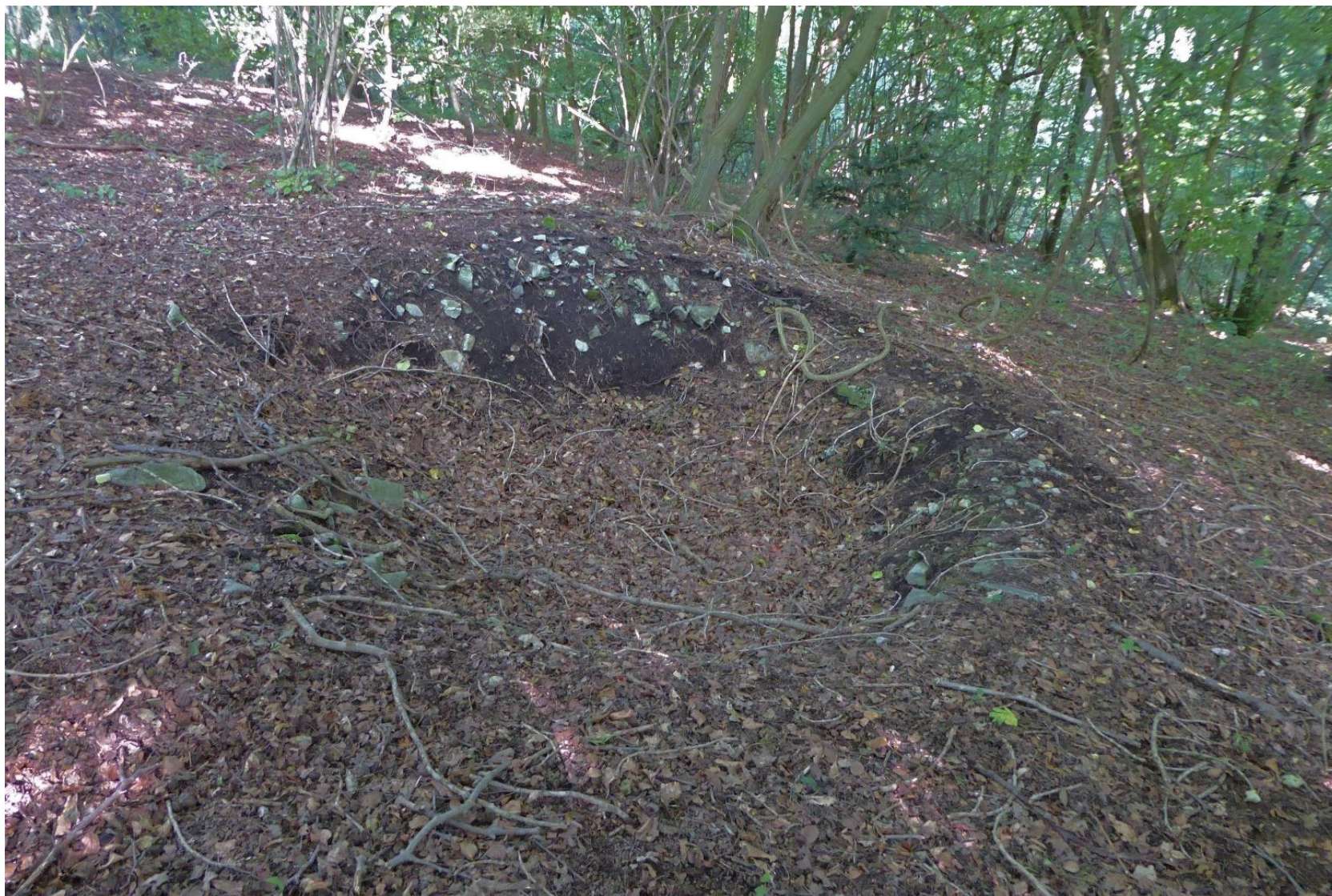
Affaissement sur un puits dans le Bois de Flône
