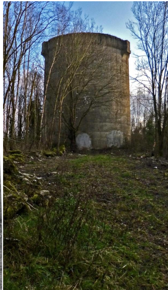
Actuellement, le carneau a été enlevé et l'entrée bétonnée.
