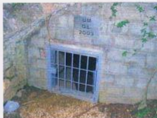
Photo n°27 : Grille de la Galerie Laminne
