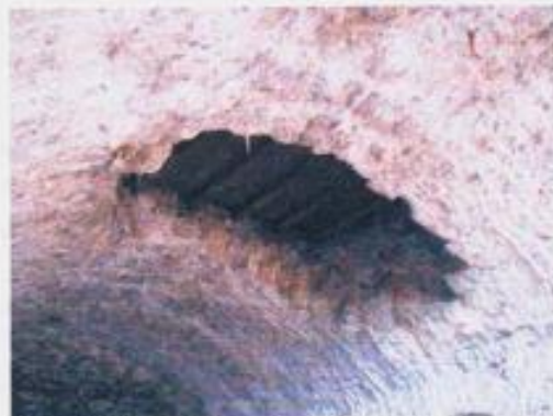
Photo n°26 : Ouverture dans la voûte
