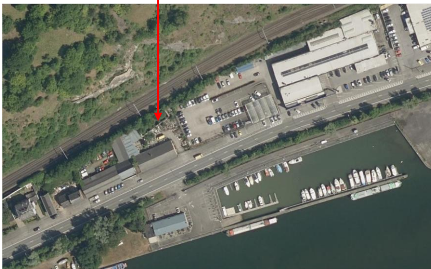
Les principaux vestiges de l'usine à zinc de Corphalie sont ces quelques murs
